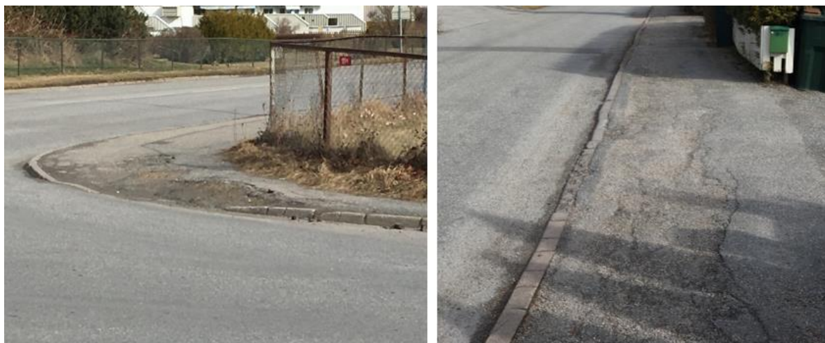
Figur 10: Dårlig dekke i fortauene i området. T.v: fortauet i krysset BRA-veien x Båstadlundveien. T.h: Fortauet i Frøyas vei.
