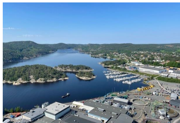
Figur 6 Fabrikkområdet sett fra toppen av Nexans-tårnet. Kilder: GPA befaring Nexans
