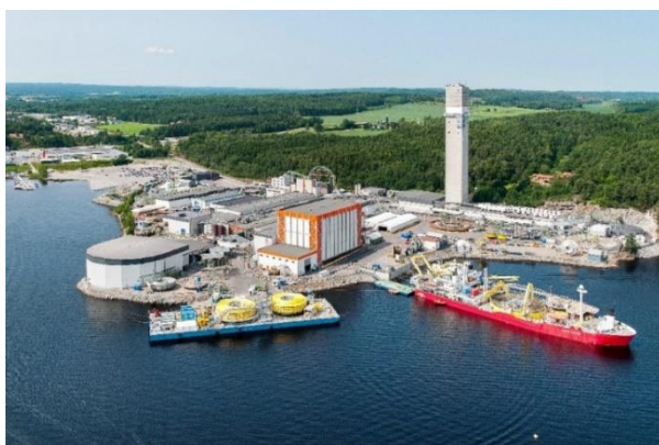
Figur 5 Oversiktsbilde av fabrikkområde, sett fra sørøst Kilde: Nexans
