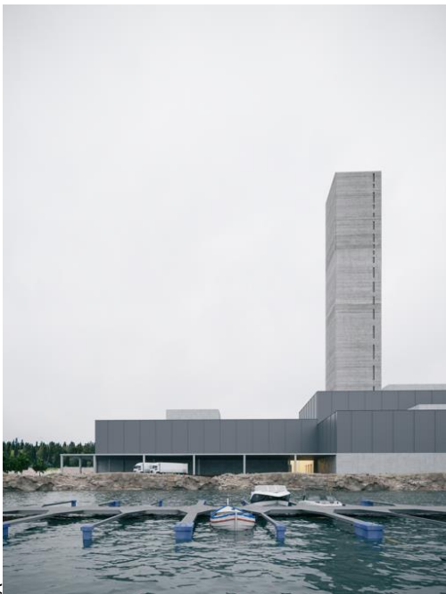
Figur 23 Nytt bygg sett fra småbåthavnen
