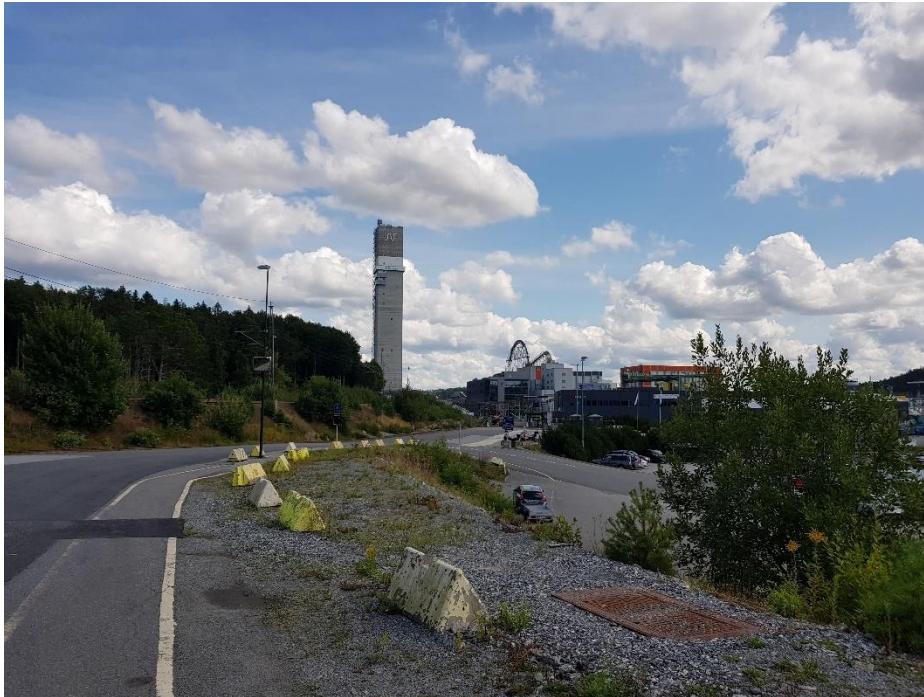
Figur 20 Eksisterende gang- og sykkelvei langs Knivsøveien
