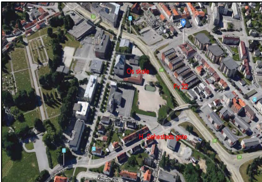
Fig 4 Oversiktsbilde med angivelse av holdeplasser (fra Google Maps, sett mot sør)
