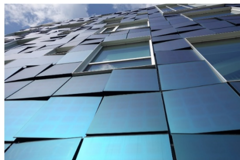
Figur 6: Rammeløse solcellepaneler integrert i fasaden til den Internasjonale skolen i København.
