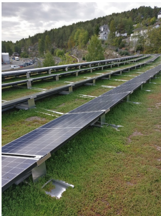
Figur 5: Solceller kombinert med grønt tak.
