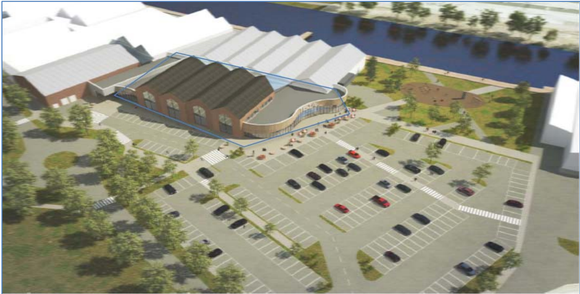
Figur 3: Oversiktsbilde planlagt utvidelse, sett fra nordvest. Utvidelse av området er vist med blå avmerking.
