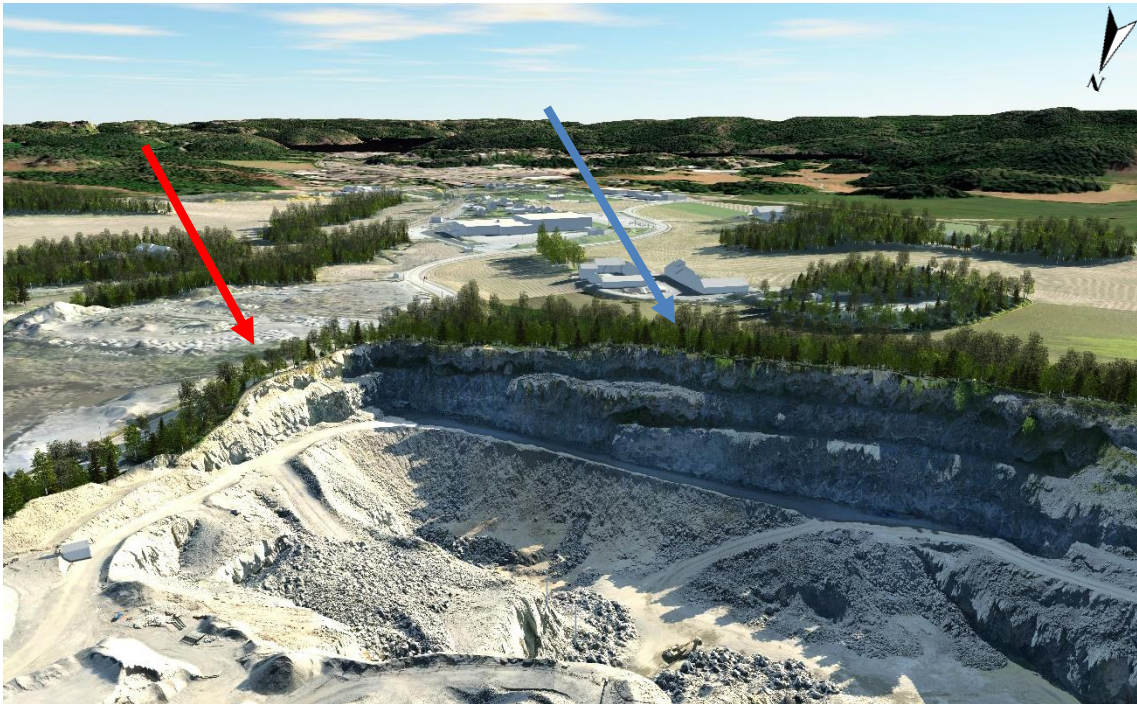
Figur 31: Illustrasjon fra modell som viser «dagens» situasjon i Svingen pukkverk sett i retning fra nord mot sør.
