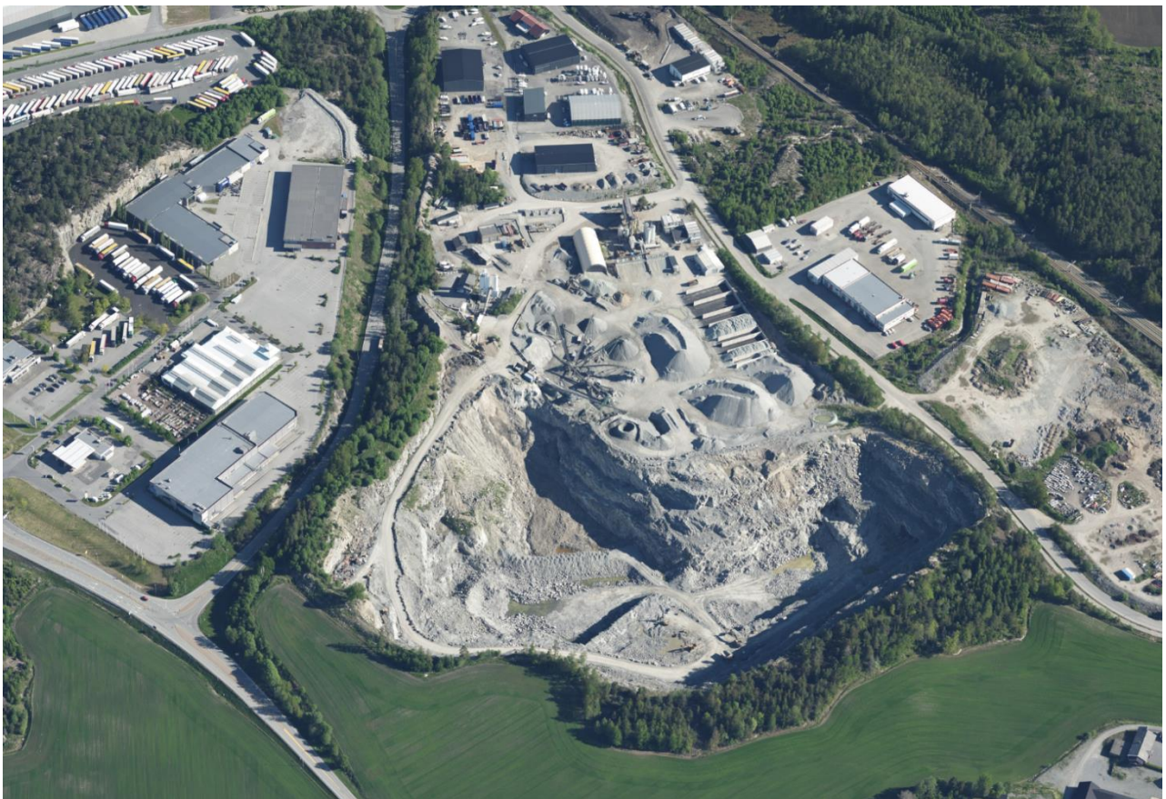
Figur 8: Skråfoto av masseuttaket og tilgrensende områder sett mot nord. Kilde: 1881.no.
