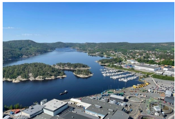
Figur 6 Fabrikkområdet sett fra toppen av Nexans-tårnet. Kilder: GPA befarings Nexans
