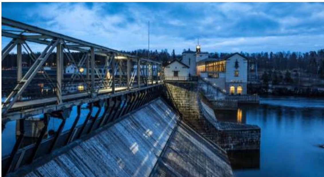
Bilde 1: Rånåsfoss kraftstasjon, et industrielt landemerke. Foto: Tomasz Majewski. Lysdesign: Light Bureau.
