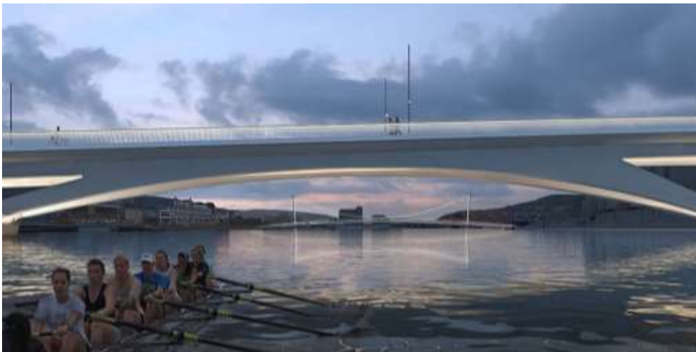
Bilde 7: Drammen bro, lysstyring gjør at riktige lysnivåer kan settes og tilpasses tid på døgnet og
