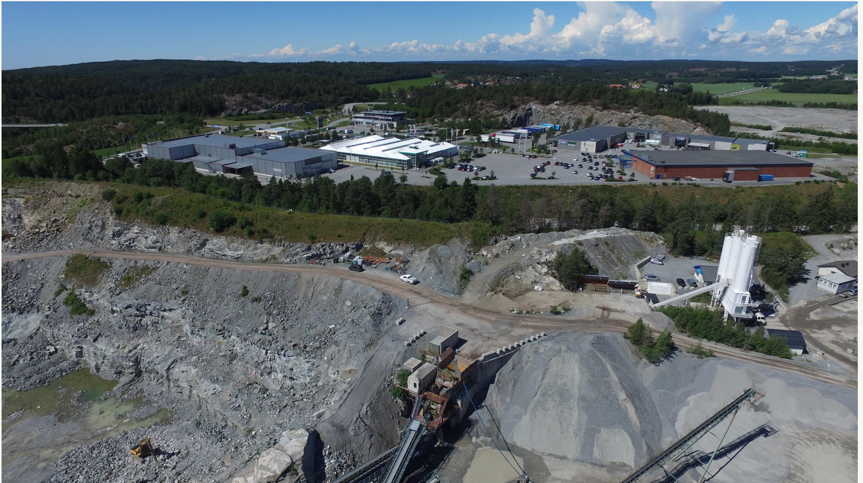
Figur 4 Pukkverket sett mot vest. Næringsområdet Svingenskogen i øvre bildehalvdel. Mellom buffersonen og Svingenskogen går fv. 118.
