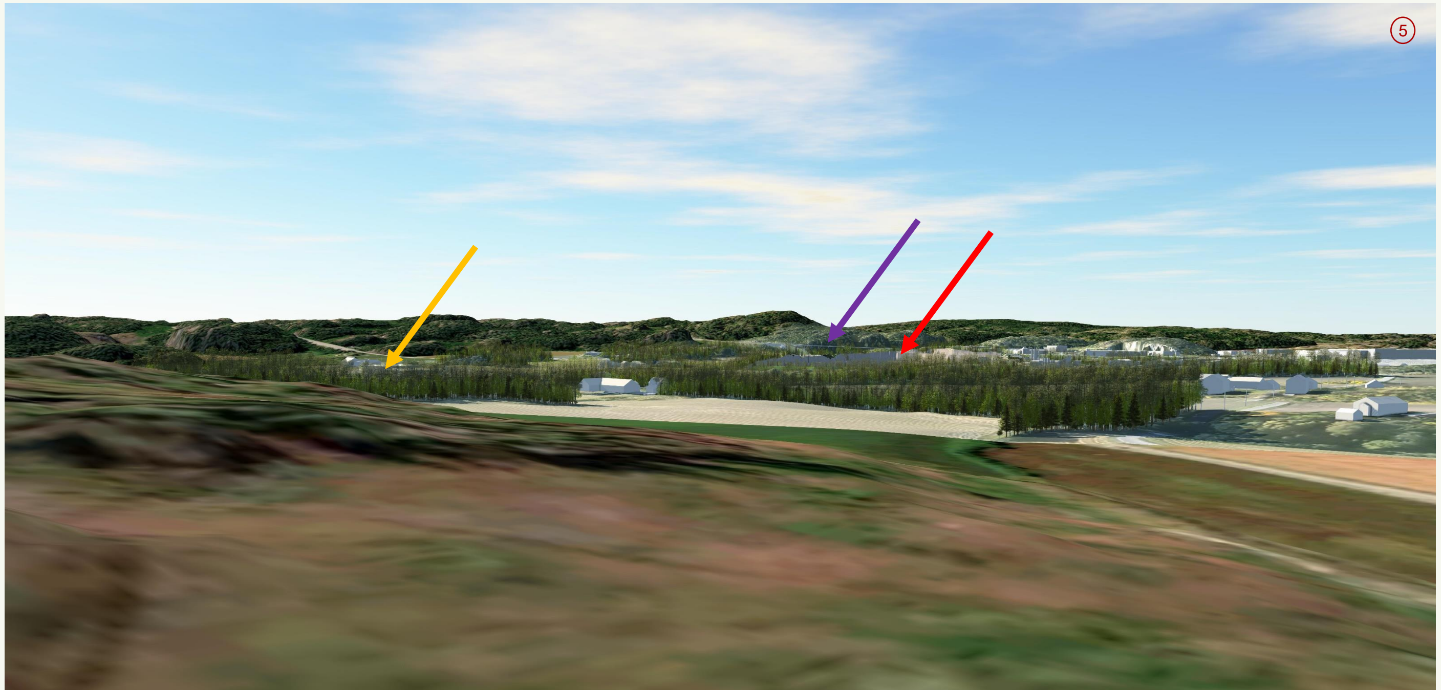
Figur 17 Ny situasjon sett fra Homannsrøset, bildestandpunkt 5 i kart på s. 10 (Figur 7). Perspektiv fra høydedraget øst for Svingen pukkverk. Dagens pukkverk er synlig, men avstanden gjør det vanskelig å skjelne hva man ser.
