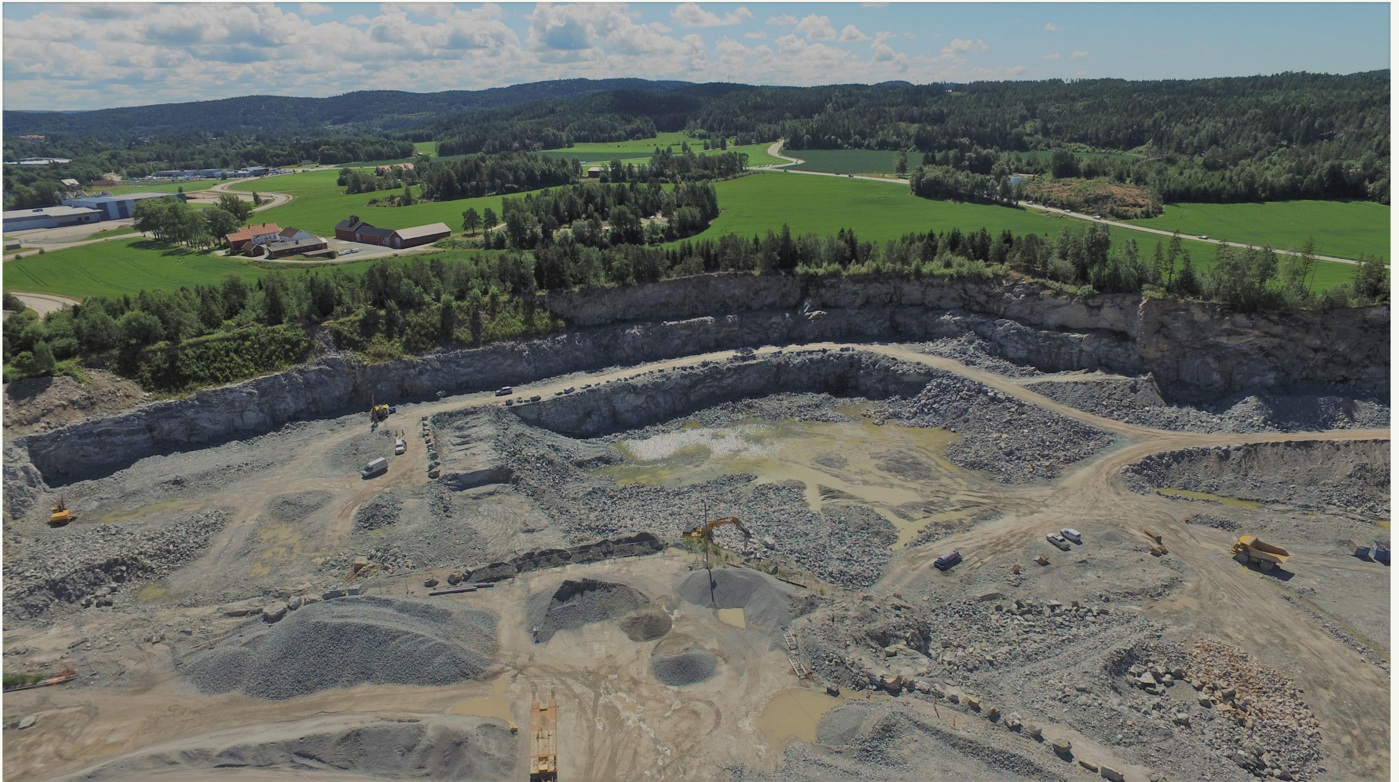
Figur 2 Dronefoto som viser pukkverket sett mot sørvest. Gården Vestgård nærmest i venstre bildehalvdel, Svinesundsveien mot høyre. Gamle Svinesundsvei tar av mot sør omtrent midt i bildet.
