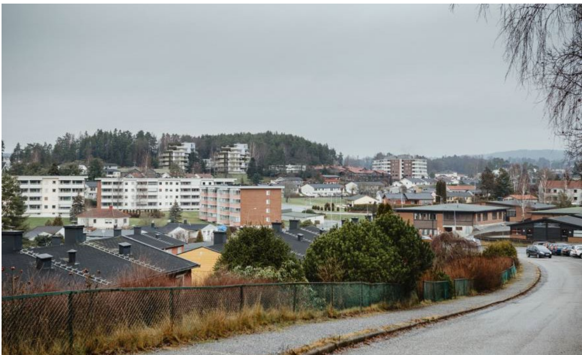
Planområdet og ny bebyggelse i maks. regulerede høyder, sett fra Likollveien (ved nr. 19)
