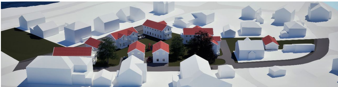
Orøveien i forkant – sett fra vest.
