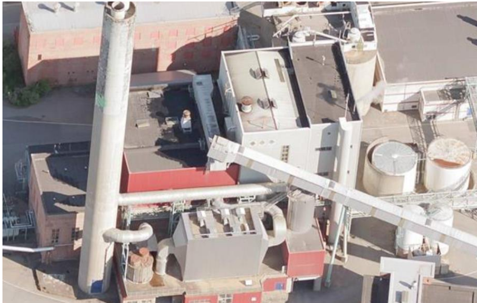
Figur 3: Oversiktsbildet av eksisterende biobrenselanlegg.
