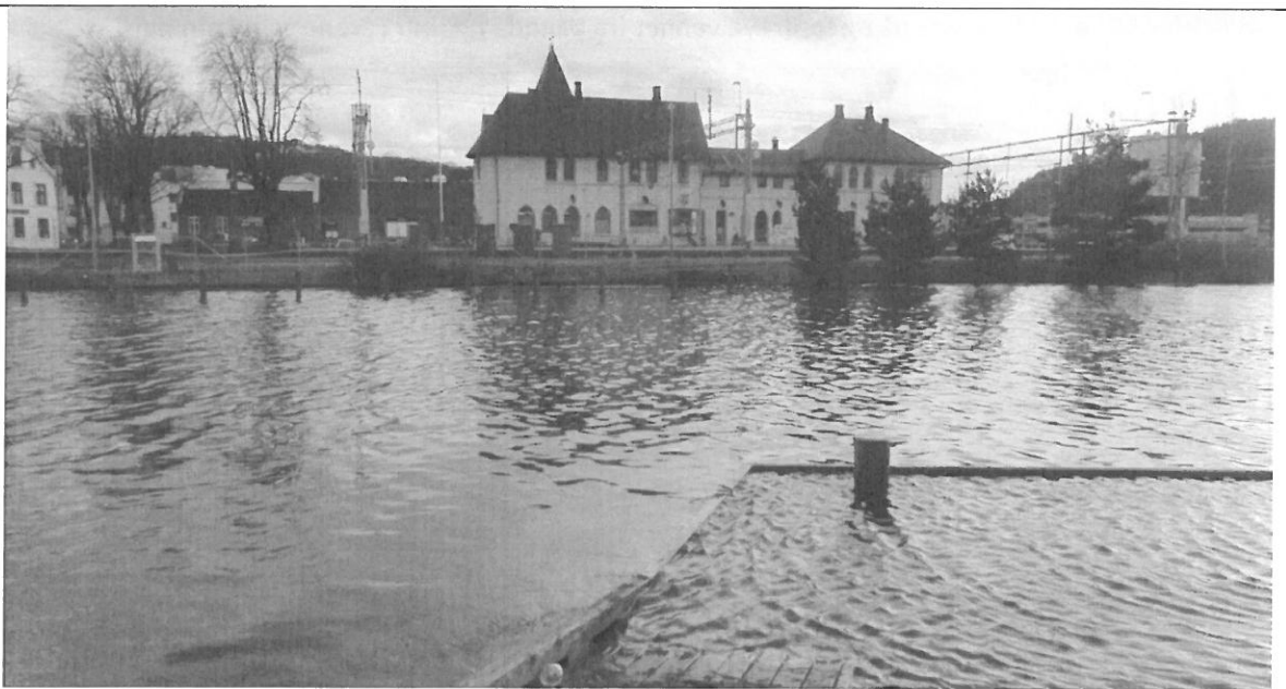
Halden jernbanestasjon ved springflo i januar 2017. Det er kort vei opp til skinnegangen.
