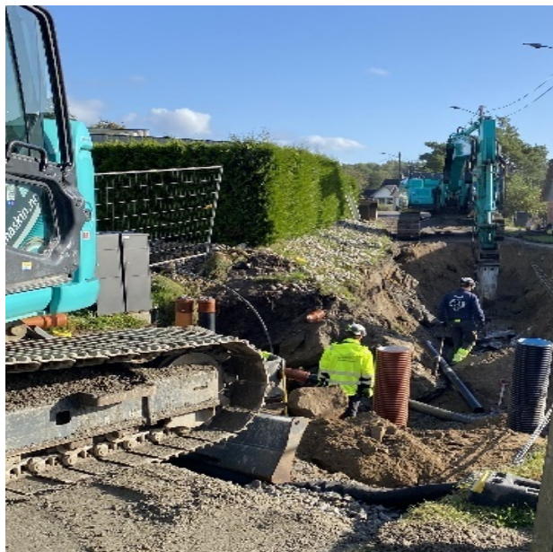
Fornyning av vann- og avløpsledninger i Toppveien, utført i egenregi
