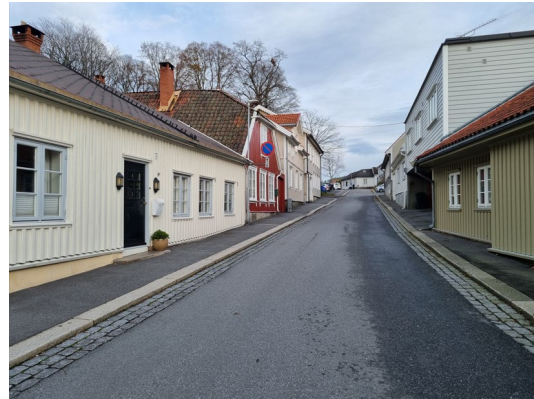
FIG. 61 ASFALTGATE MED RENNER AV STORGATESTEIN
