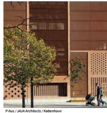
P-hus / JAJA Architects / København
