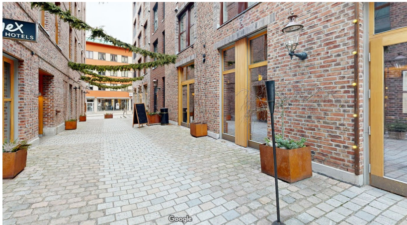
FIG. 54 EKSEMPEL PÅ RULLEVENNLIG DEKKE PÅ NYGÅRDSPLASSEN I FREDRIKSTAD. SAGET OG FLAMMET STORGATESTEIN I GANGSONENE (GOOGLE STREET VIEW 2024)
