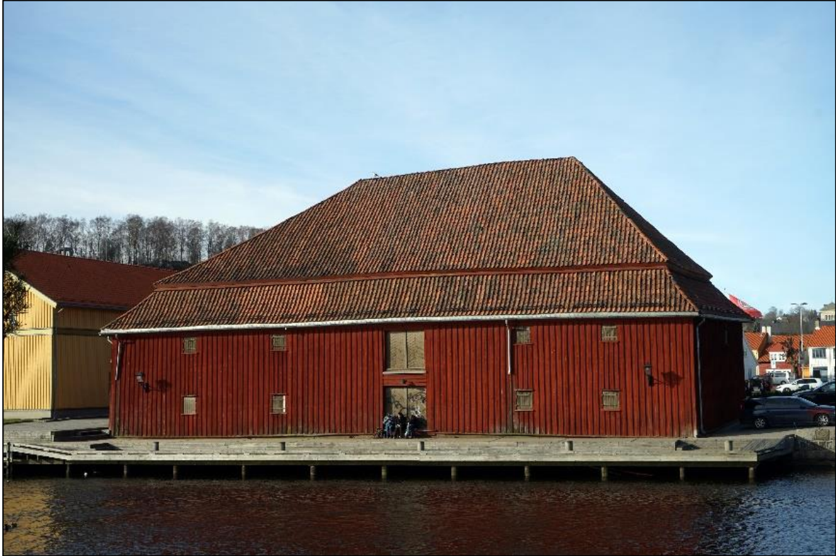
Figur 16. Spinneriboden slik den i dag framstår mot Tista. Eksisterende fasadeåpninger begrenser utnyttelsesmulighetene, men kan samtidig gi spennende muligheter.
