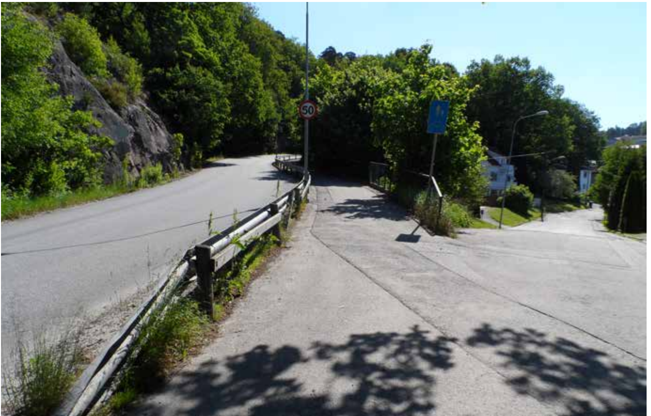
Figur 40: Hovsveien med gang- og sykkelveg, her adskilt fra kjøreveg med rekkverk
