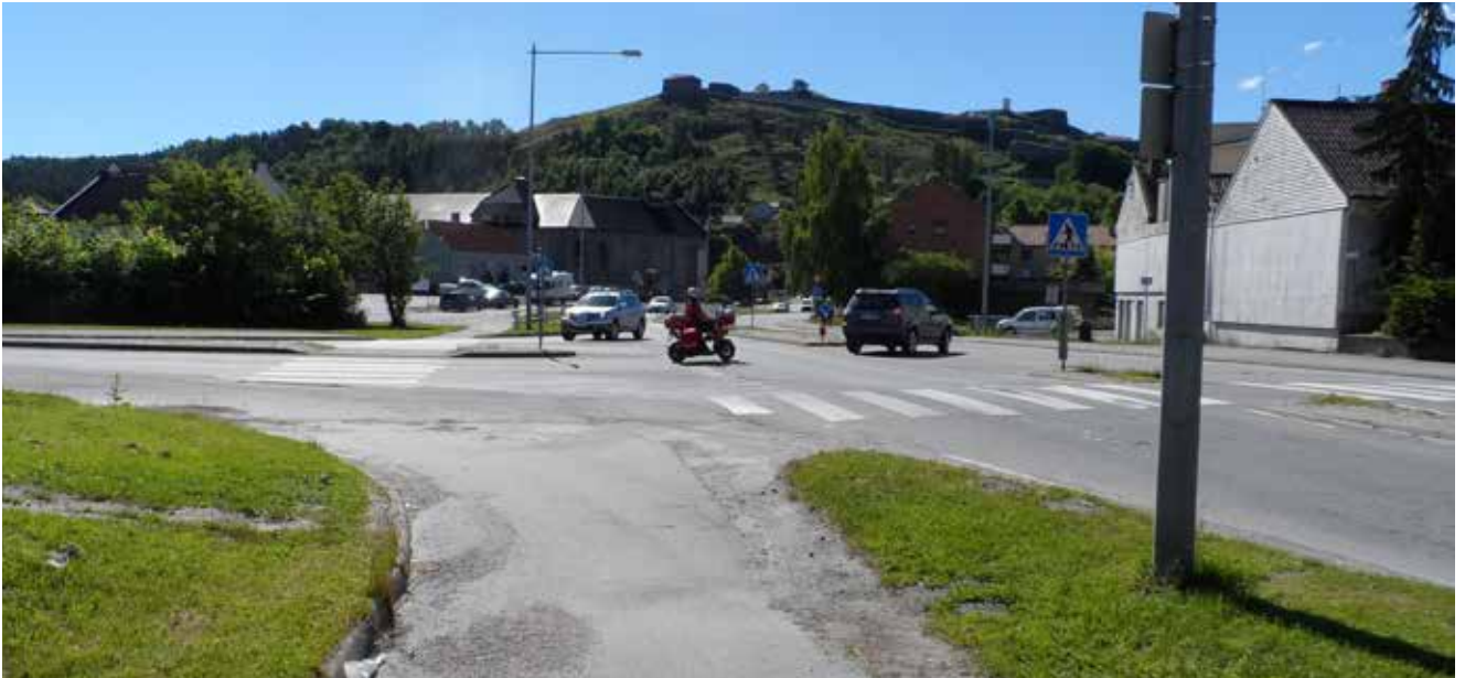
Figur 21: Lenke 1.7. Eksisterende gang- og sykkelveg langs fv. 22 mellom Halden Bad og Vaterland bru
