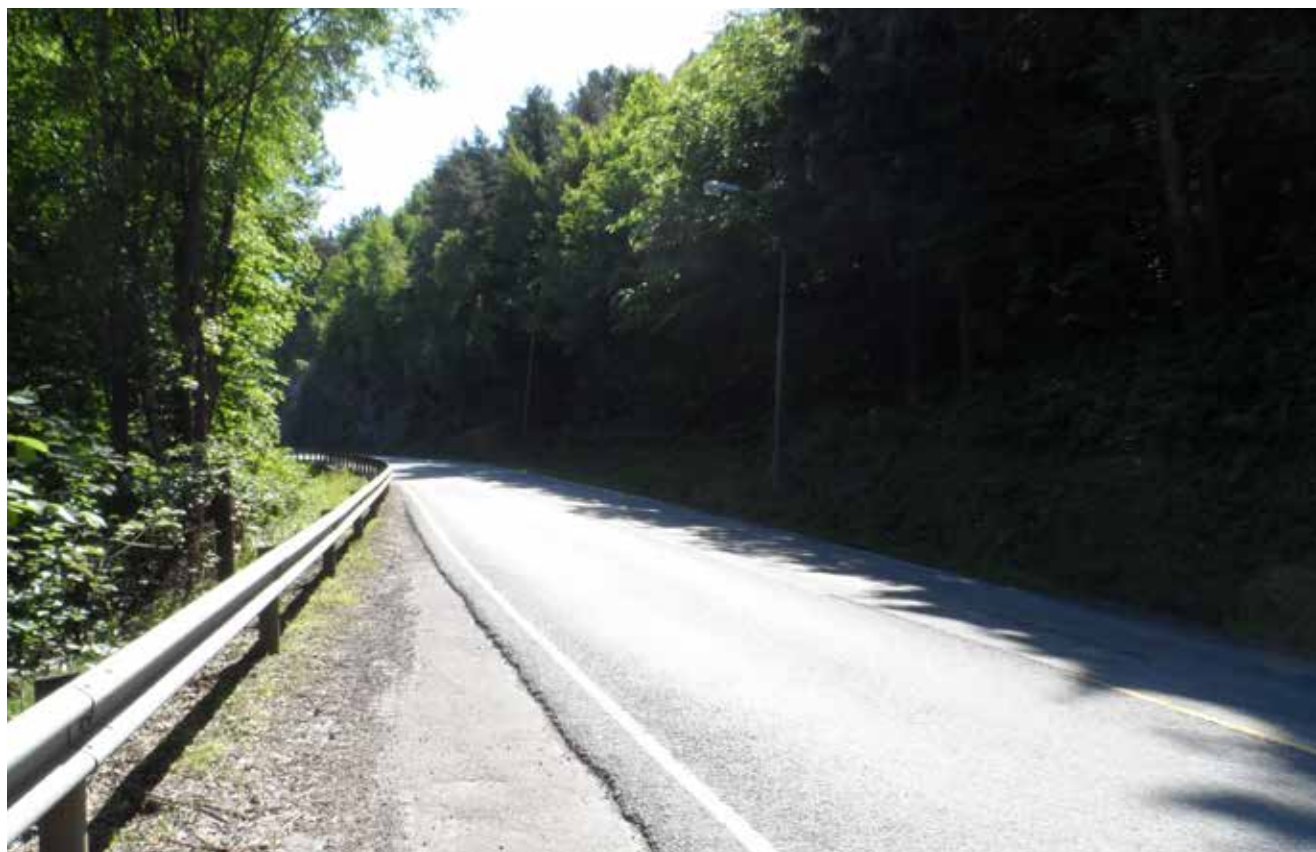
Figur 42: Fv. 22 Iddeveien er smal og bratt på begge sider
