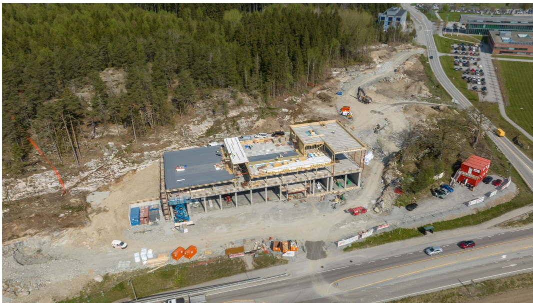
Den nye brannstasjonen under bygging.
