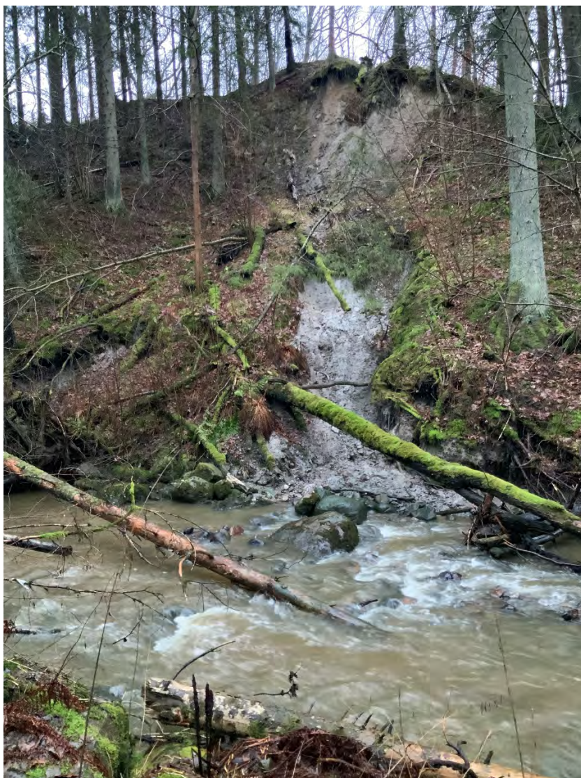
Figur B4 Utglidning i løsmasser fra knekkpunkt ravine. Bratt ned mot bekk, noe berg i dagen lengre oppstrøms.
