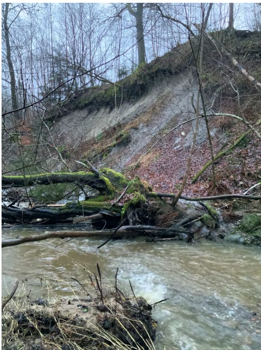
Figur B6 Utglidning i løsmasser, svært bratt ned mot bekk.
