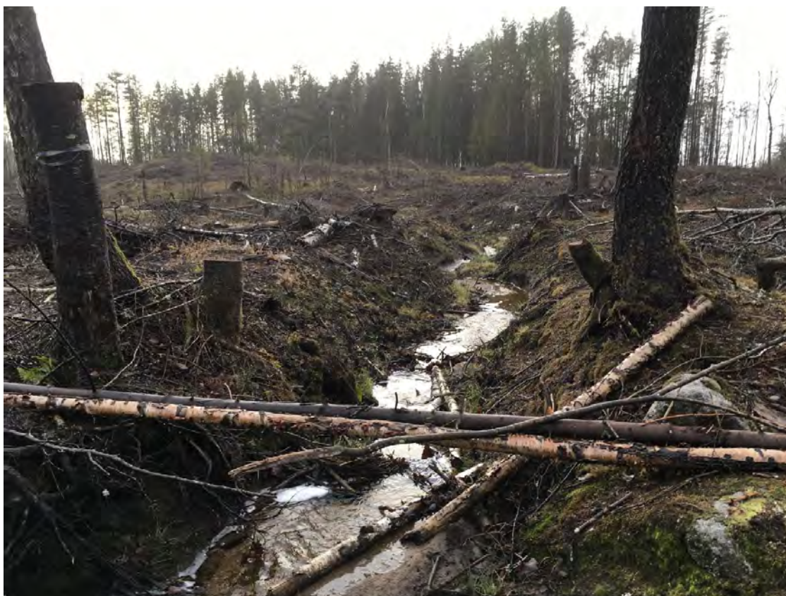
Figur B21 Også på de mellomliggende områder med løsmasser er det indikasjon på berg i dagen. I reguleringsplan bør vannhåndtering inn som tema, slik at en ikke ender opp med et lukket system.
