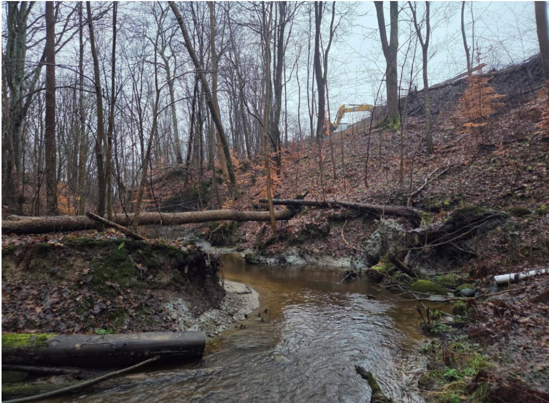
Figur 6-8: Bilde tatt mot sør. Pågående erosjon i skråning.
