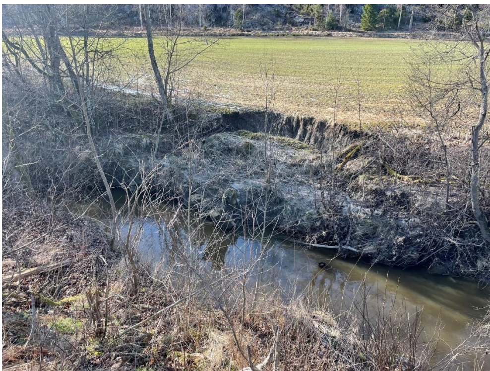
Figur 4-4 Furuvarpbekken. Kjøring tett på skråningstoppen fører lett til utrasing (foto: Mats Finne 2023).
