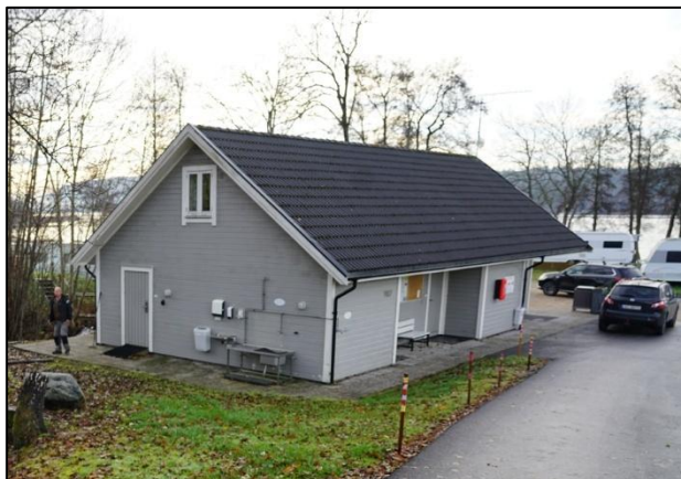
Figur 12. Eksisterende servicebygg er ført opp som en trebygning med saltak.
