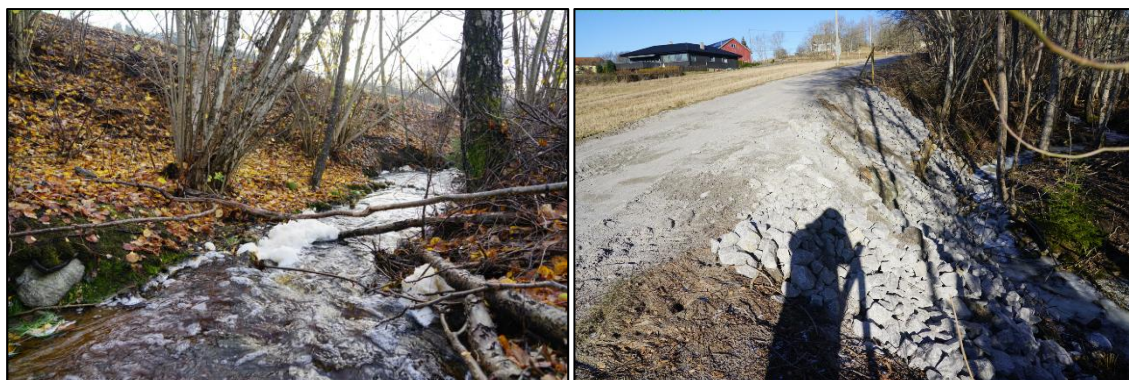
Figur 23. Fotografiet til venstre viser et representativt utsnitt fra den øvre delen av bekkeløpet på en dag med mye vannføring. Her ligger bekken forholdsvis dypt i terrenget, omgitt av fylldig kantvegetasjon som til en viss grad binder løsmassene.
