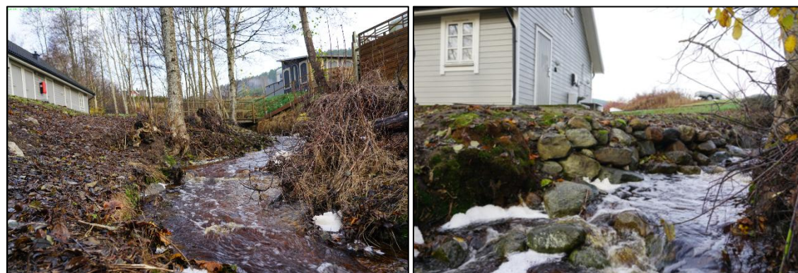
Figur 22. Fotografiet til venstre viser bekkeløpet forbi campingområdet. Som bildet viser, skal det mye nedbør til før vannet stiger opp til campingvognene. Flomfaren i området vil trolig være mest knyttet til episoder der bekken skifter løp. I bildet skimtes en klopp som er bygget over bekken. Denne kan forsterke en flomsituasjon ved at vann stuves opp.
