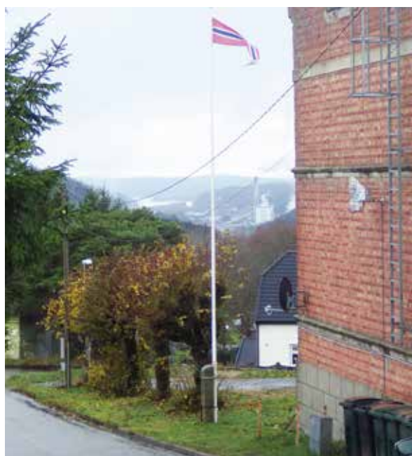
Siktlinjene fra Veden til Halden by
