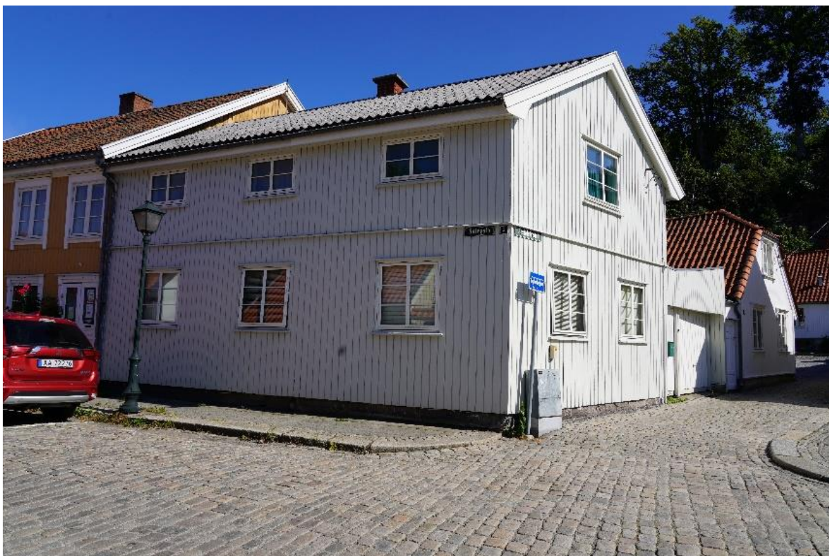
Sølvgate 5, fotografert i 2021, etter uheldig renovering av fasadene på 1970-tallet, og verneverdien falt. (foto Andreas Ebeltoft)
