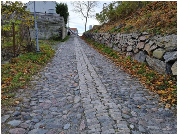
FIG. 4 GASSVERKSBAKKEN VED PORSNES. DETTE DÉKKE ER OPPRINNELIG.
