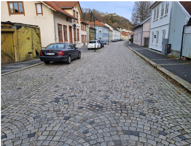
FIG. 22 NYTT BROSTEINSDÉKKE I DAMHAUGGATA. FORTAU I ASFALT, PLATEKANTSTEIN OG RENNEN I GRANITT
