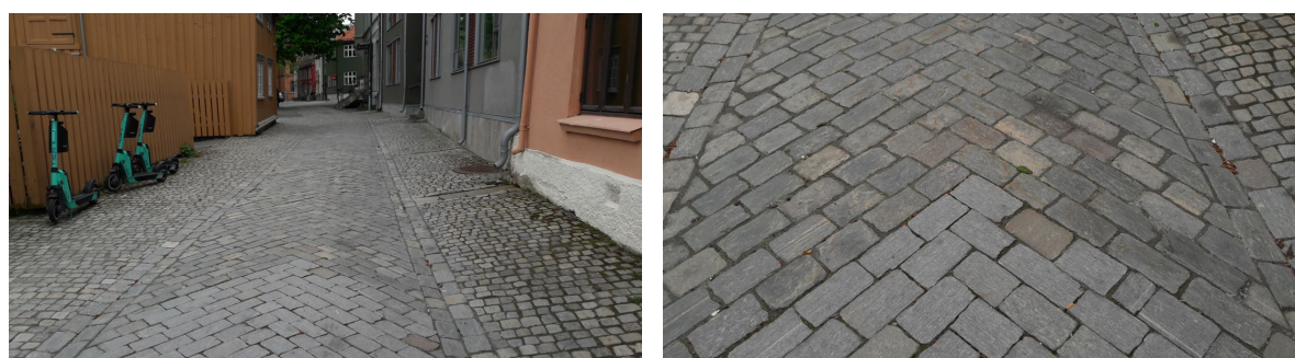
FIG. 30 OG 31 RULLEVENNLIG DEKKE – SAGET OG FLAMMET STORGATESTEIN I EN VEITE I TRONDHEIM.
