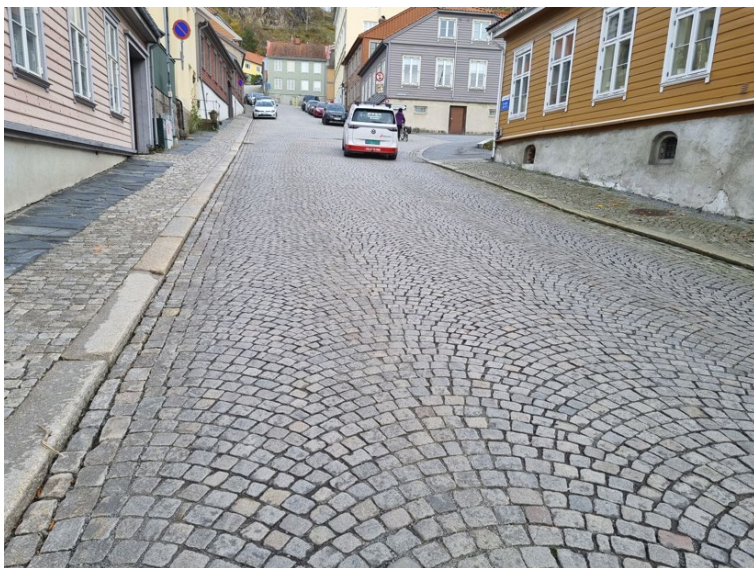
FIG. 6 FESTNINGSGATA I DAG. BROSTEINSDÉKKE AV SMÅGATESTEIN I BUEMØNSTER. PÅ FORTAUET ER DET OGSÅ BROSTEIN OG NOE RESTER AV OPPRINNELIG SKIFERDÉKKE.
