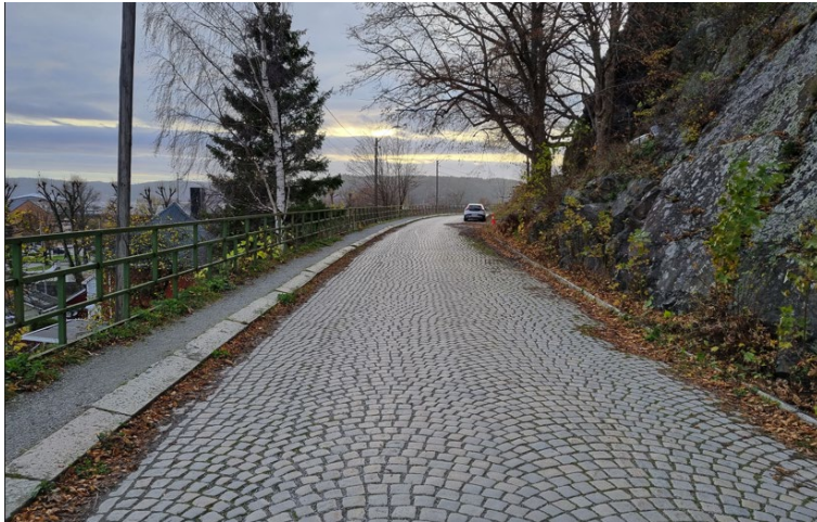
FIG. 7 BROSTEINSEKKE I RØDSVEIEN. DETTE VAR TIDLIGERE HOVEDVEIEN INN TIL HALDEN SENTRUM FRA VEST. DENNE GATA HAR IKKE VÆRT SATT PÅ NYTT ETTER DEN BLE STEINSATT PÅ 1930-TALLET.
