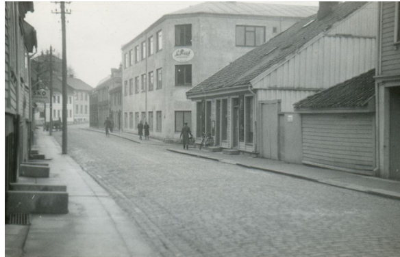
FIG. 12 SKIPPERGATA MED BETONGFORTAU (1949)
