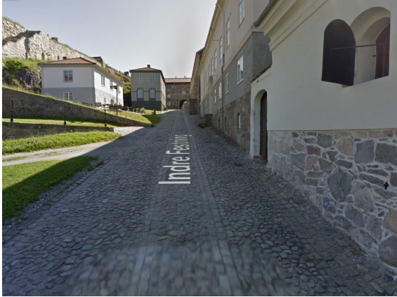
FIG. 2 INDRE FESTNING MED KULLERSTEIN OG STORGATESTEIN I TRILLESJOR OG RENNEN.
