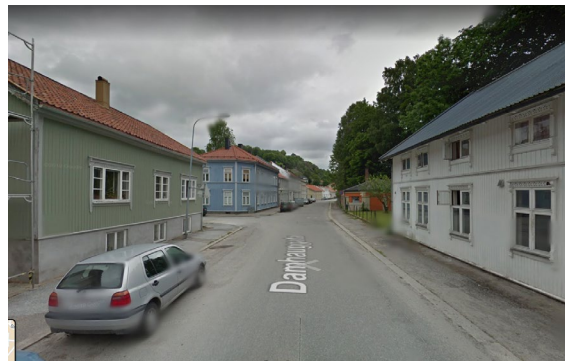
FIG. 24 DAMHAUGGATA FØR REHABILITERINGEN
