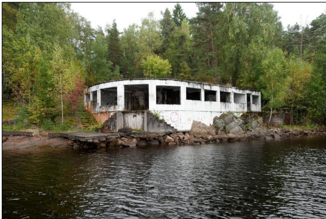
Figur 8. Eksisterende betongkonstruksjon sett fra sjøen.
