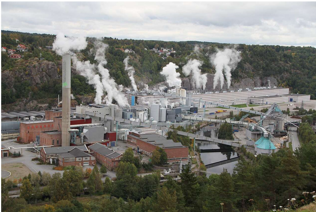
Figur 4-5 industriområdet har bygninger fra ulike tildepoker med de eldste på «Kaken» i vest. Bak bygningene synes den bratte skrenten og over elven går flere transportbånd. Foto: (Bjørtned 2012).
