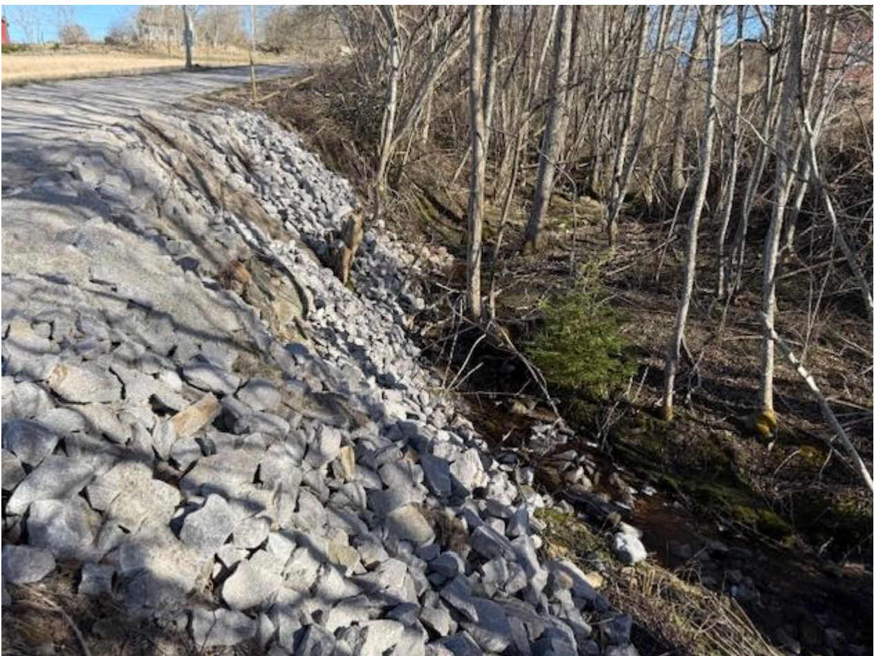
Figur 16 adkomstvei med stabilisert vegskulder mot lokal bekkeløp
