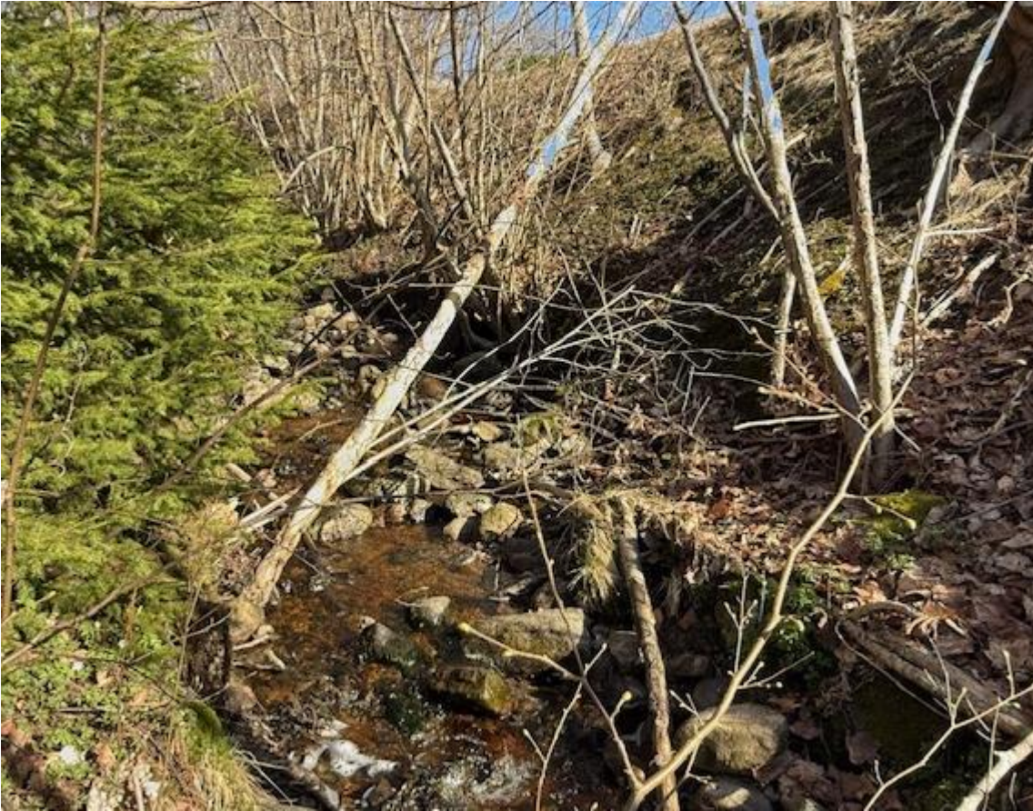
Figur 11 lokal bekkebunn nord for servicehuset
