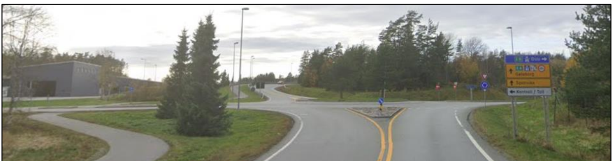
Bilde 4: Sponvikveien, sett mot vest, mot rundkjøringen ved Svinesund tollstasjon. Kilde: Google street view.
