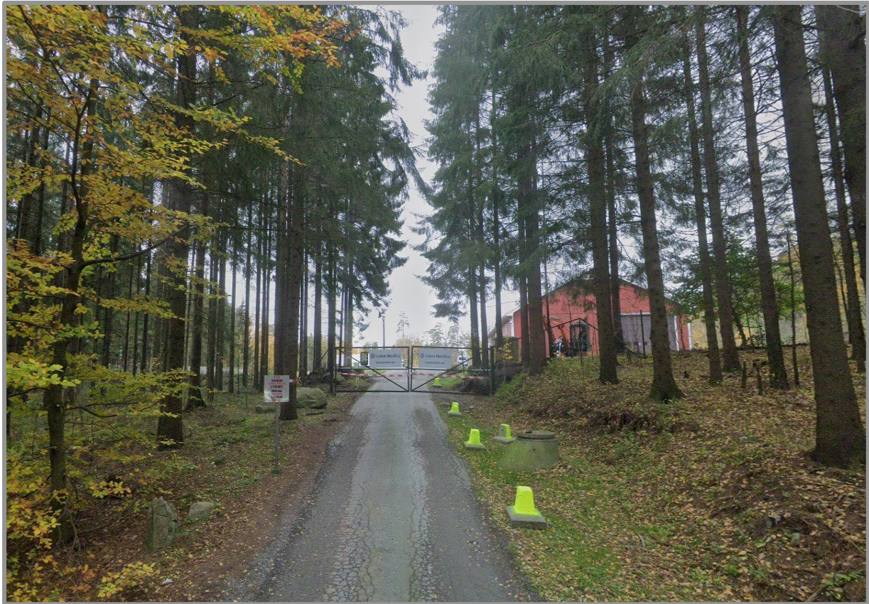
Figur 34a: Bildet er tatt fra privat adkomstveg og mot Torpumveien 309 (Google maps). Vi ser eksisterende kontorbygg og verksted. Området fremstår som et næringsområde. Det er gjennom reguleringsbestemmelsene tillatt ett nytt bygg. Dette skal tilpasses eksisterende bygningsmasse. Skogen som omkranser dagens miljøpark består i hovedsak av granskog med innslag av lauvfellende trær.
