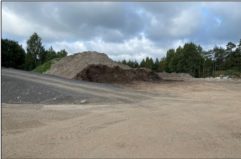
Figur 43: Bilde av masselager i de nordre områdene i miljøparken. Disse områdene har grunnforhold med fjellgrunn, og er asfalterte (bilde FNØ-12.09.23).
